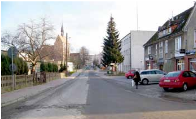
Tak wyglądało przed remontem...
