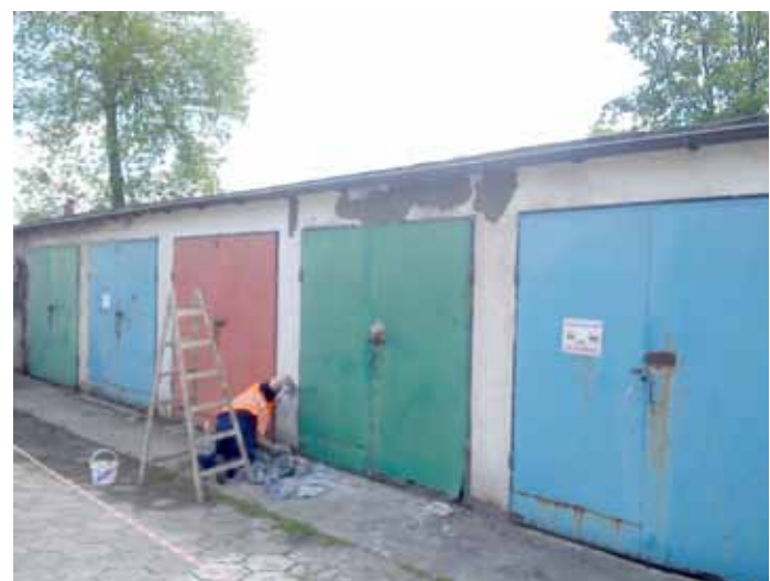
Remont elewacji przedniej ściany garaży przy szpitalu
