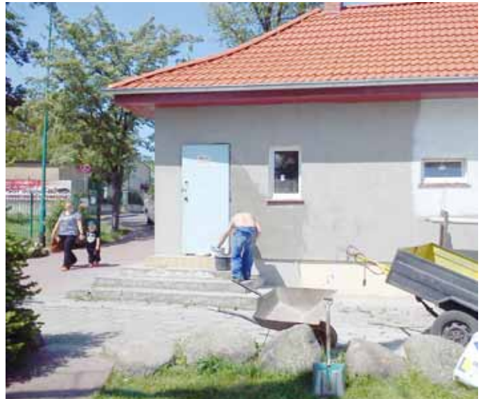
Remont elewacji budynku na plaży miejskiej
