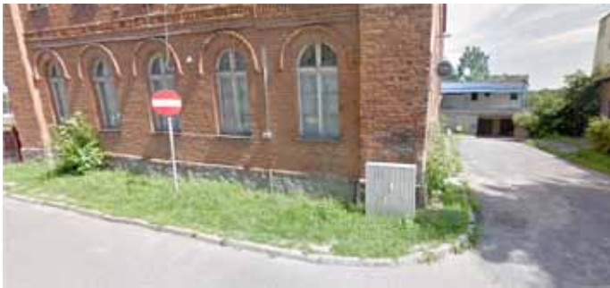
Tak wyglądało przed remontem...
