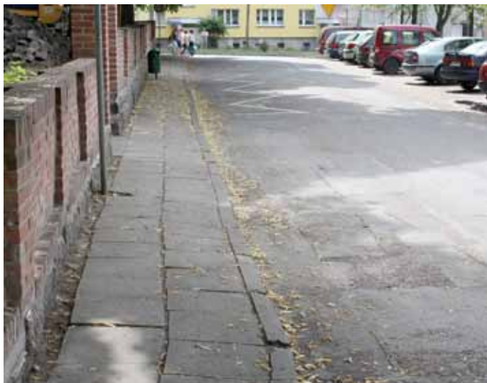
ul. Kościelna przed remontem
